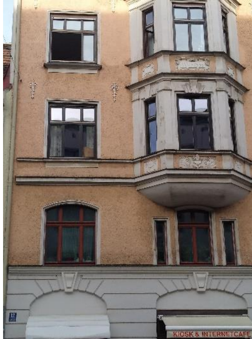
Abb. 5: Adalbertstraße 12. Foto: Dirk Heißerer.
